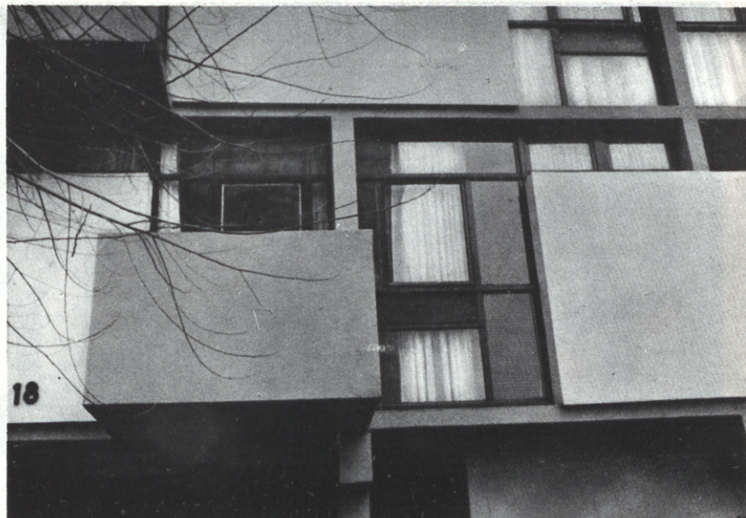
Detalle de un conjunto de 4.000 viviendas, tipo H.L.M. Sistema de prefabricación de grandes paneles. Pantin.
